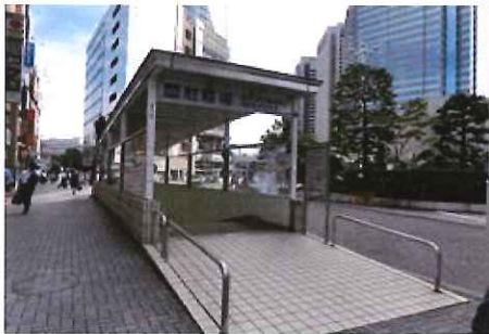
品川駅港南口駐輪場の外観
